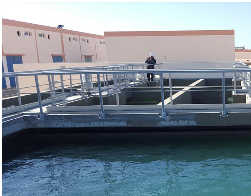
Photo 2 : La station de traitement et de déminéralisation de la ville de Dakhla
